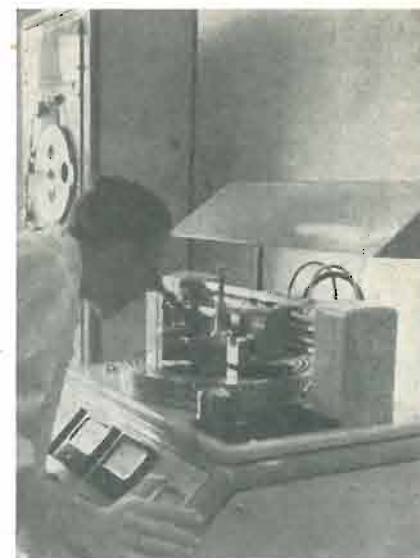
Nella sala di incisione è possibile registrare al microscopio il lavoro della punta di zaffiro. Nella foto la « macchina del drago » con a sinistra ben visibile il nastro magnetico e a destra i complicati apparecchi per l'incisione del suono sull'acetato.
